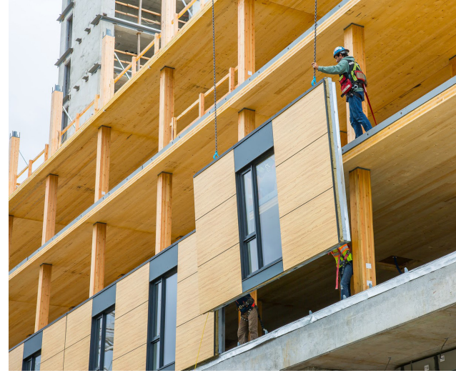
Construction bois - CLT
