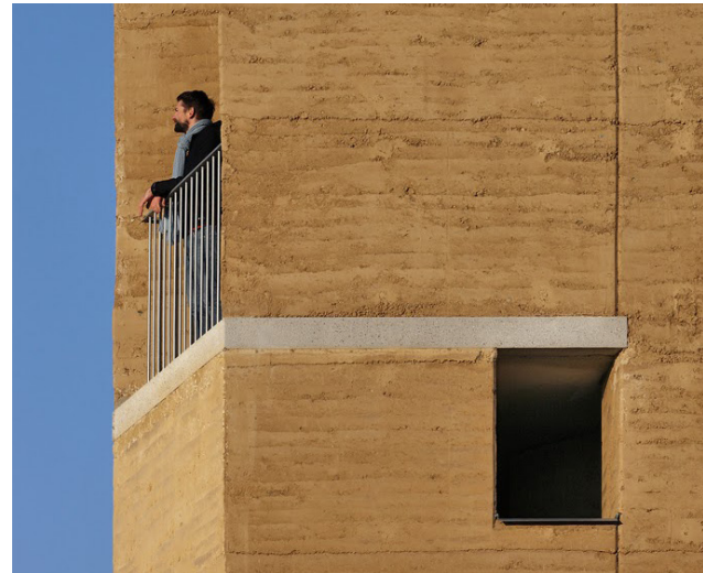
Mise en œuvre pisé & béton
