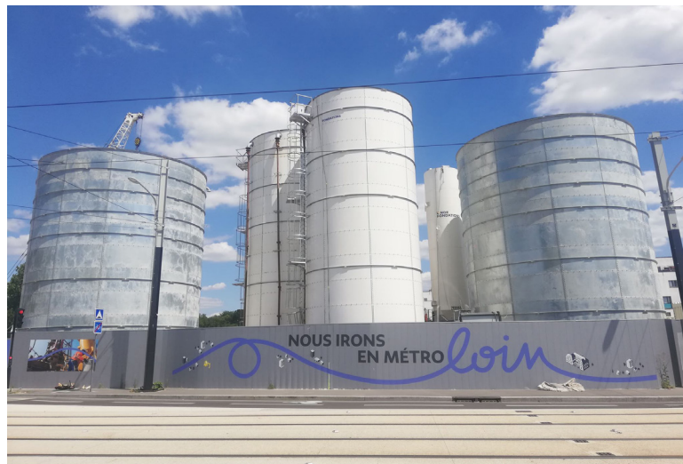
Vue piétonne sur la base vie du chantier, depuis la Dhuys (source: Encore Heureux).
