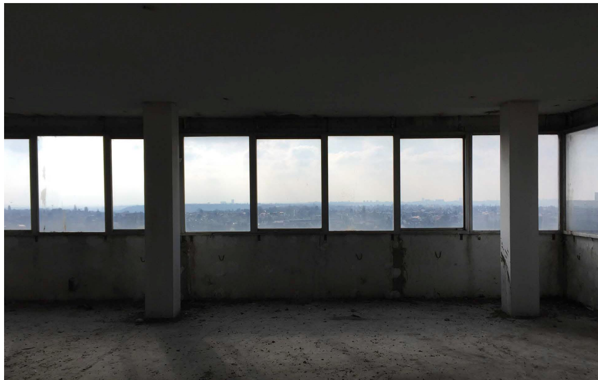
Vue panoramique depuis les derniers étages de la tour Utrillo (source: L'Ouvroir, SPEAP, 2016).
