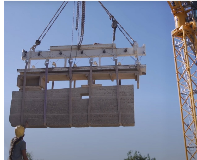
Mise en œuvre pisé - parois préfabriquée
