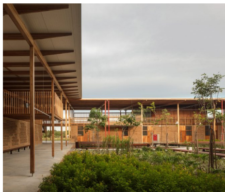
Bâtiment d'internat, Brésil
