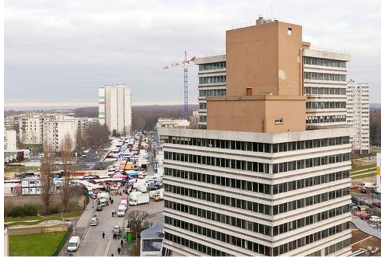
Vue de la tour Utrillo et du marché Anatole France, avant la démolition du centre commercial et de la tour.
