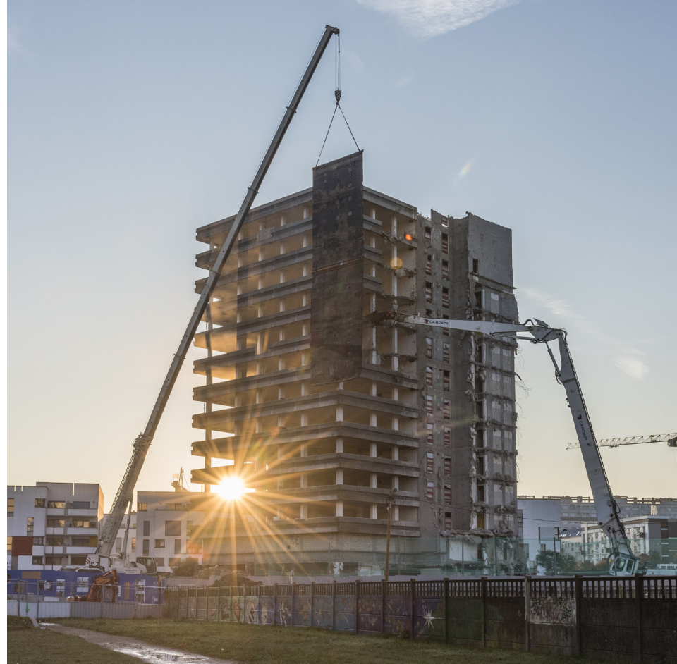
Travaux de démolition de la tour en 2017 (source: SGP).
