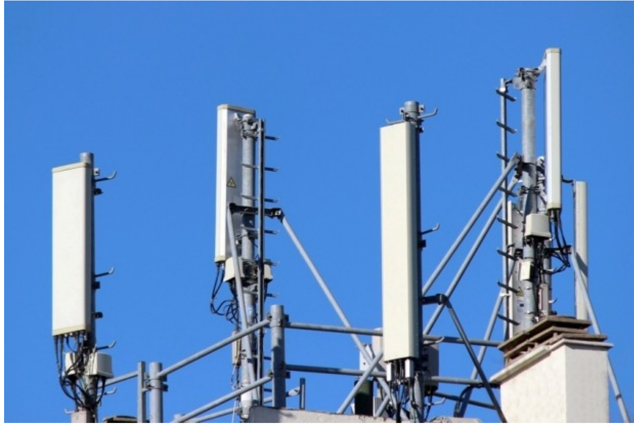
Antennes téléphoniques, France
